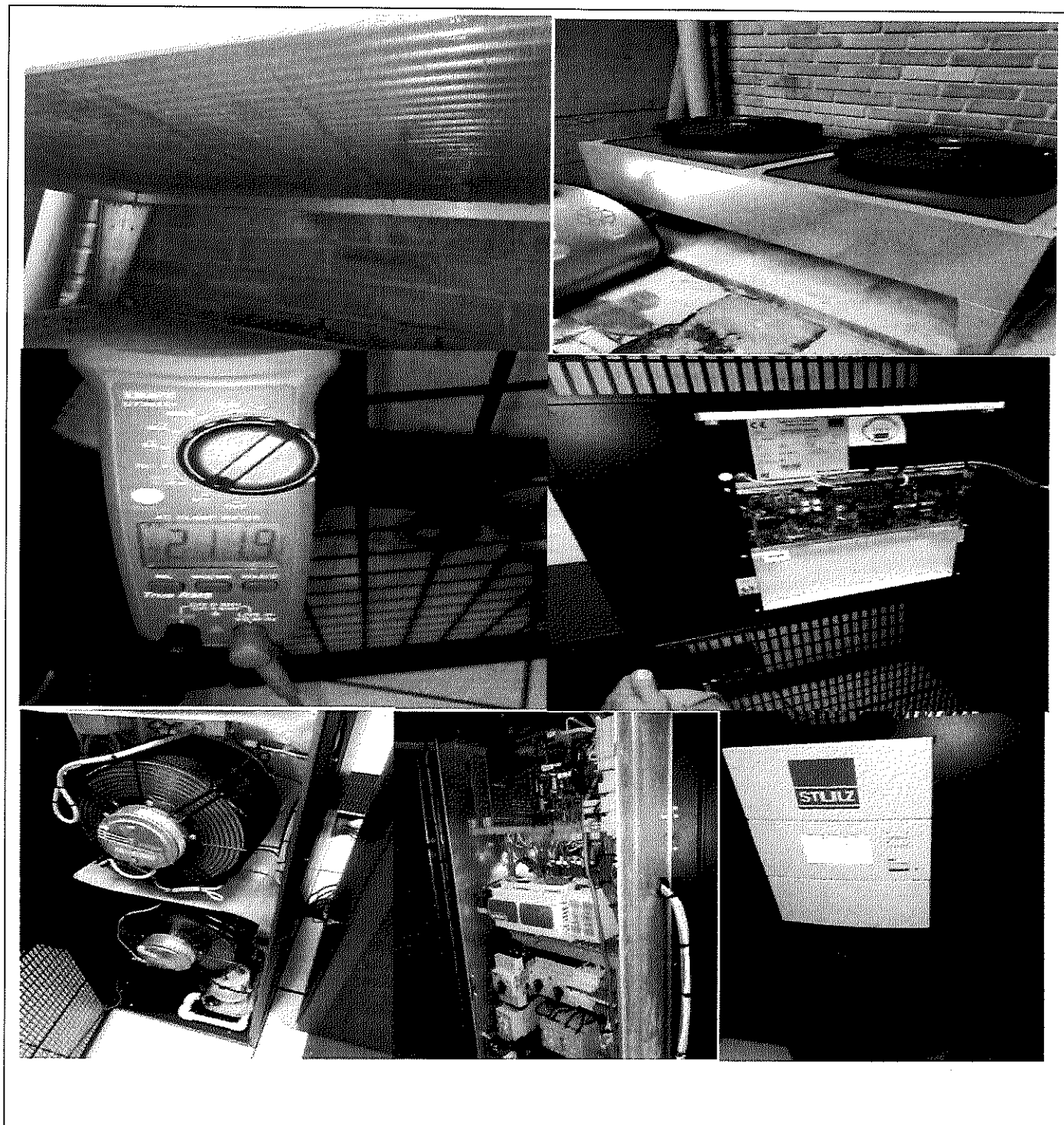
Ilustración 45 Mantenimiento preventivo aire acondicionado.
